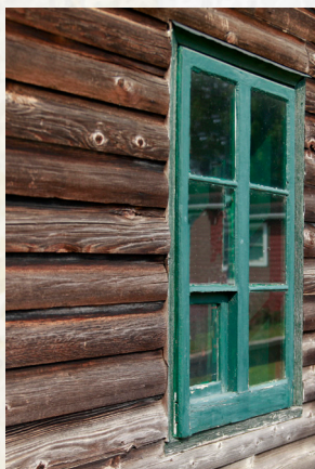
a) Fenêtre à battants français avec 6 grands carreaux
